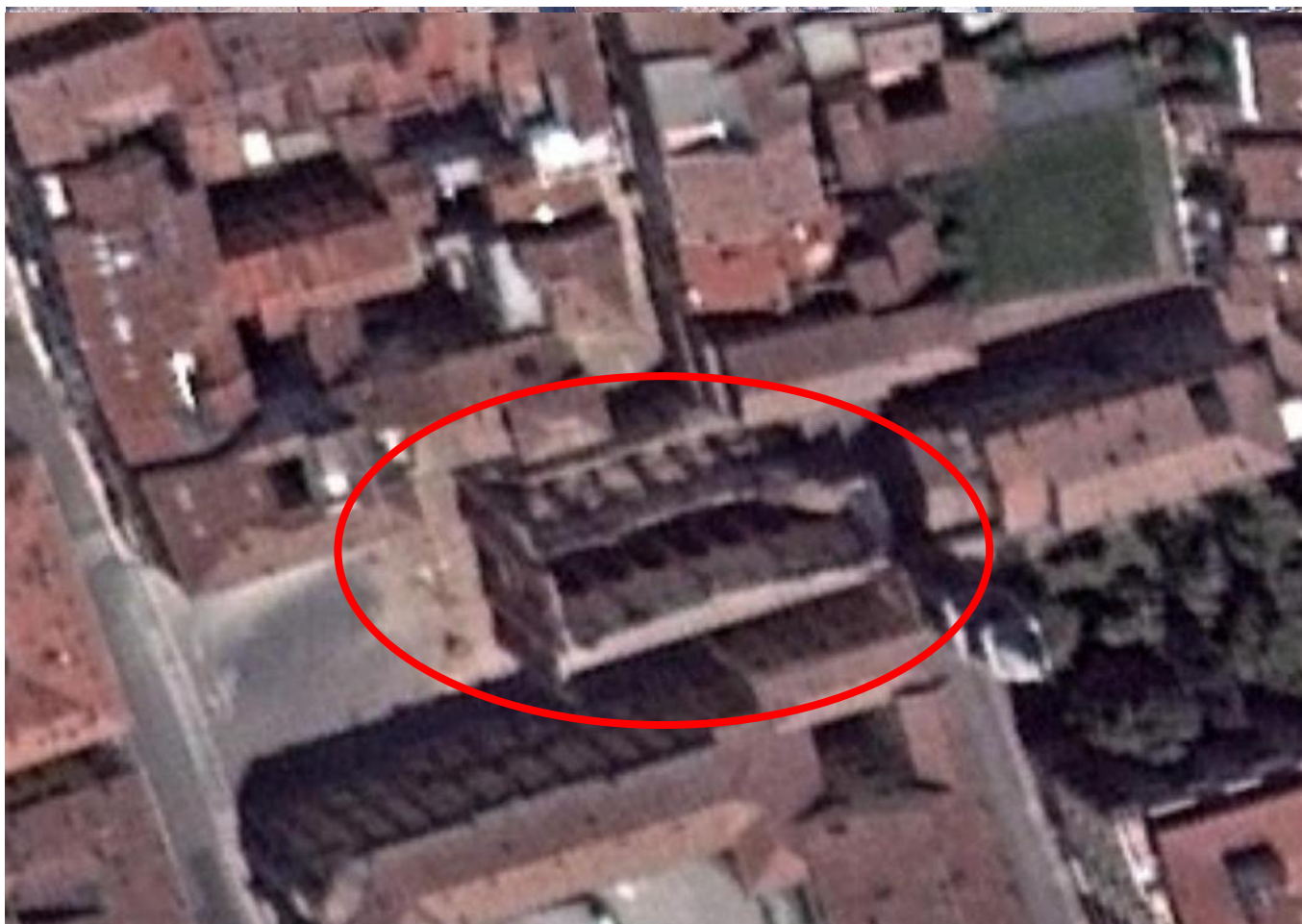
Duomo di Mirandola, 20 maggio 2012: pericolosa
